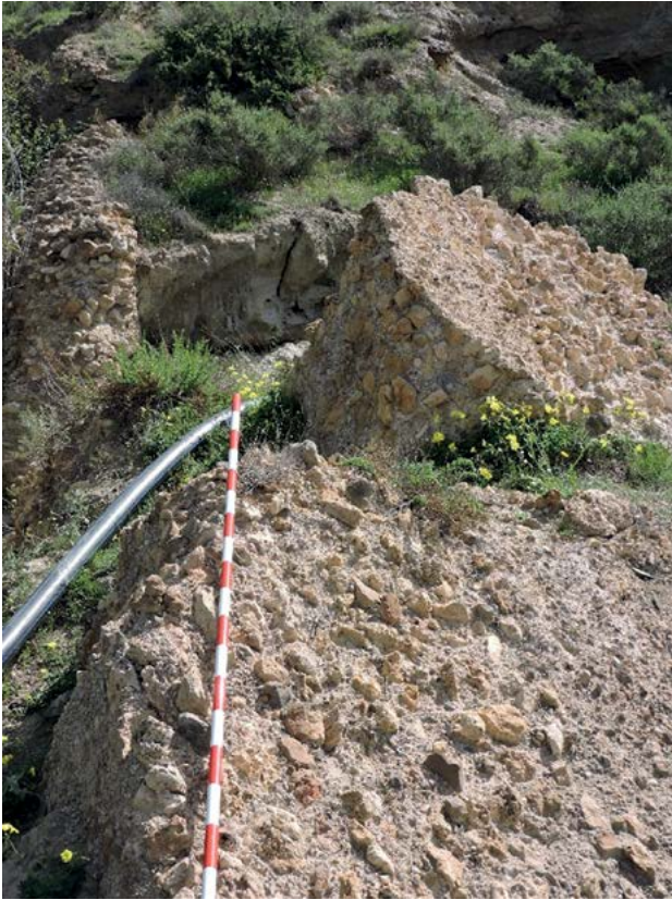
Figura 3.12. Acueducto de Urci: restos de la arcuatio.
