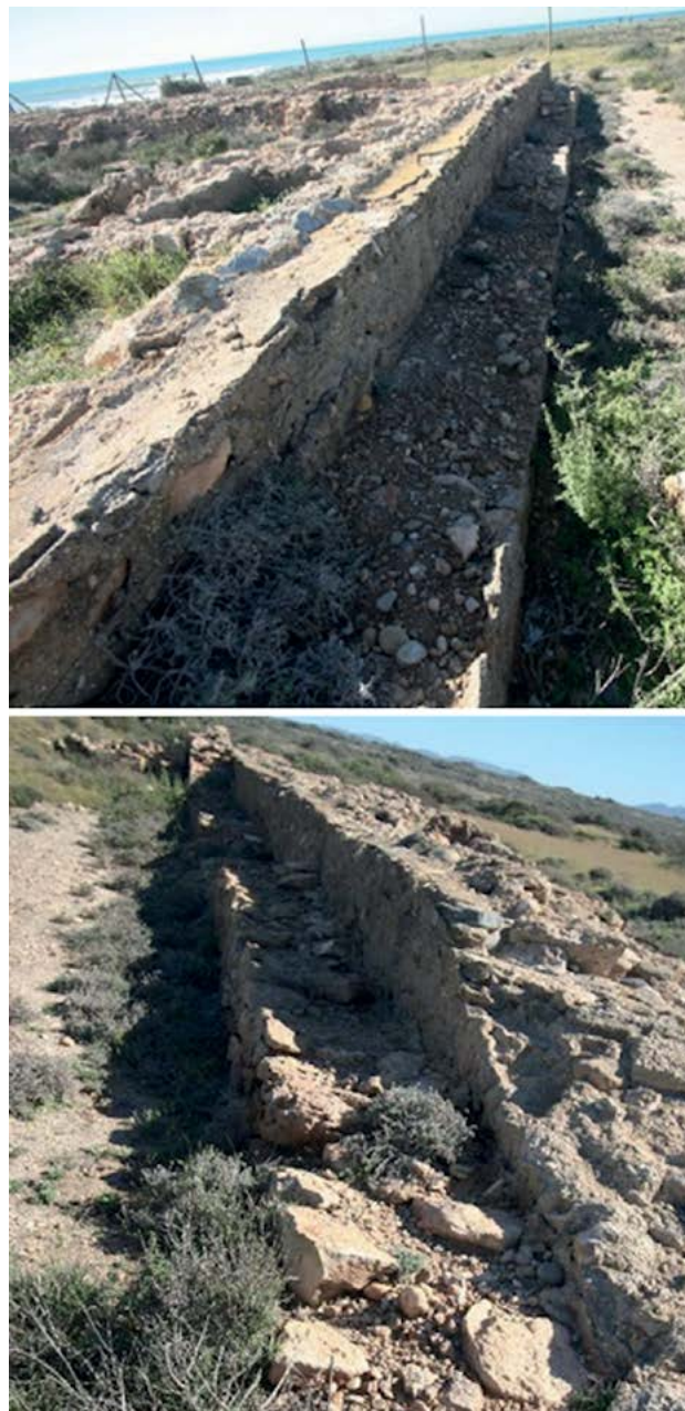
Figura 4.9. Área 1 de la Zona A: imágenes del muro perimetral.
