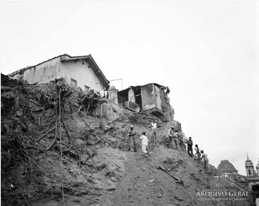
Photograph of the demolition of the Morro de Santo Antônio, Rio de Janeiro, 1950s (Arquivo Geral da Cidade do Rio de Janeiro)
