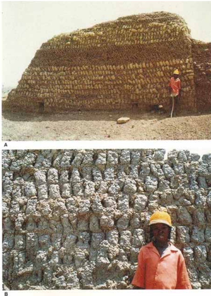
1.a. Vue du rempart extérieur sud, montrant l'utilisation de plusieurs types de briques en terre crue. 1.b. Vue du rempart extérieur ouest, montrant le détail des briques de type «djenné-fereys».
