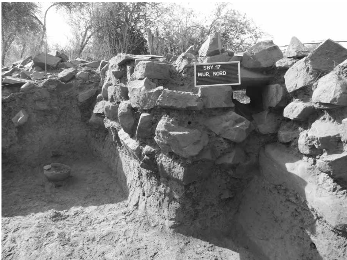
Figure 6.26. Samba Yaye, vue de la meurtrière dans le redan de la muraille.
