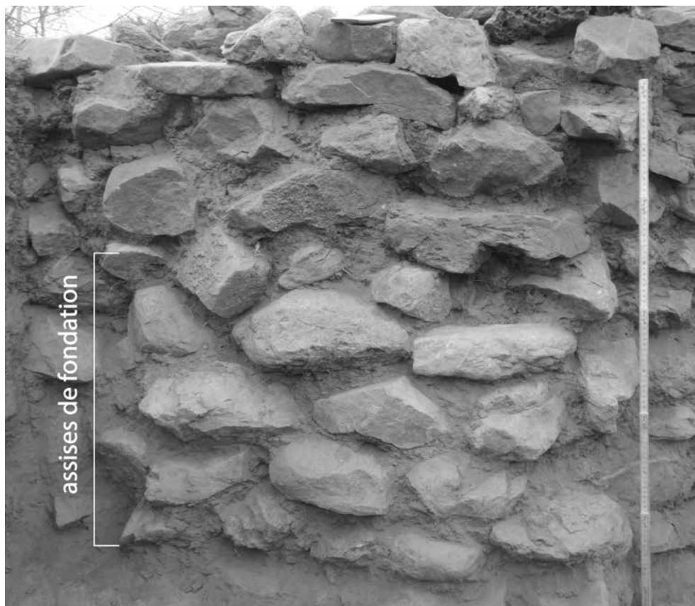
Figure 6.5. Som Som, assises de fondation et d'élévation de la muraille.
